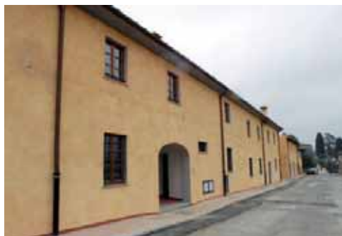
35 - Il complesso di Lappeggi
